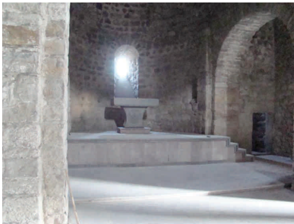
Reconstruction du chœur et nouvel autel. Dallage intérieur (2010).
