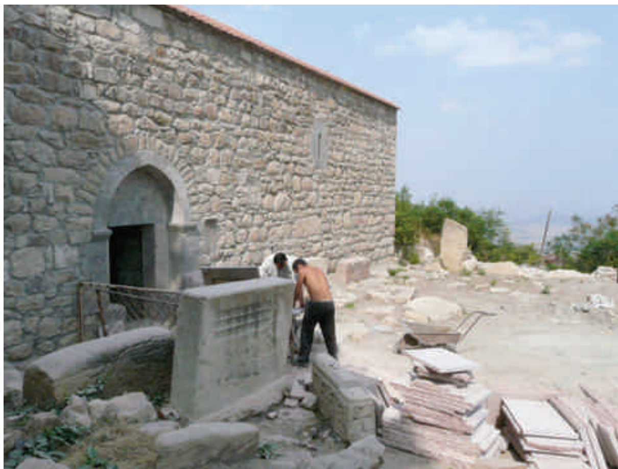
Façade sud rejointoyée (2010).
