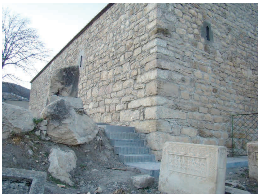
Rejointoiement : angle des façades sud et est. Installation d'une coursive dallée à escaliers sur le pourtour de l'église (2010).
