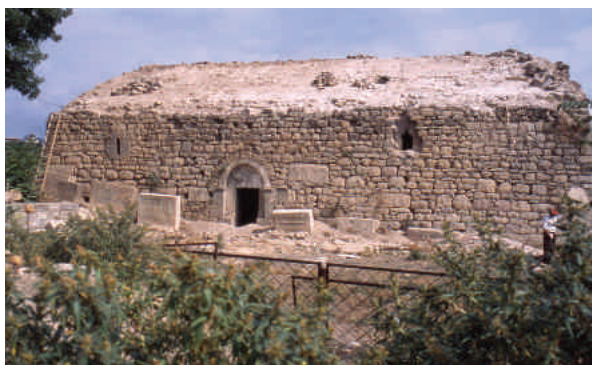
Éghwart : l'église en 2007 et au début des travaux en 2008.
