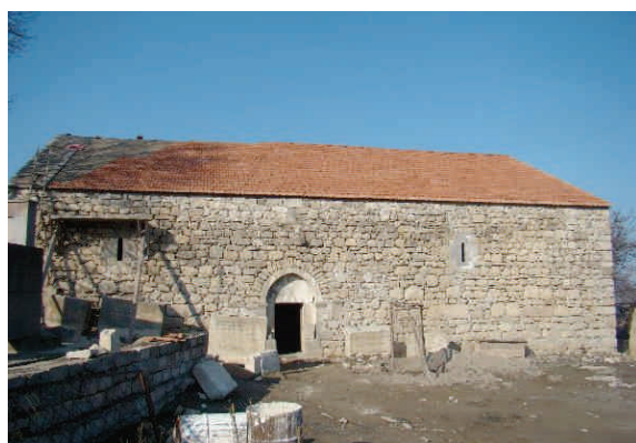
Reprise des façades, réfection du toit et pose des tuiles (2008).
