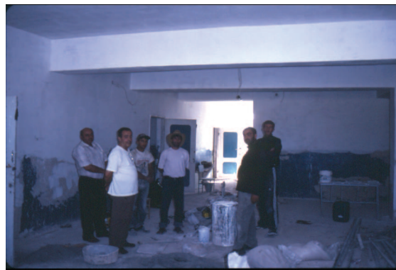
École d'Azad : rénovation en cours (2007).
