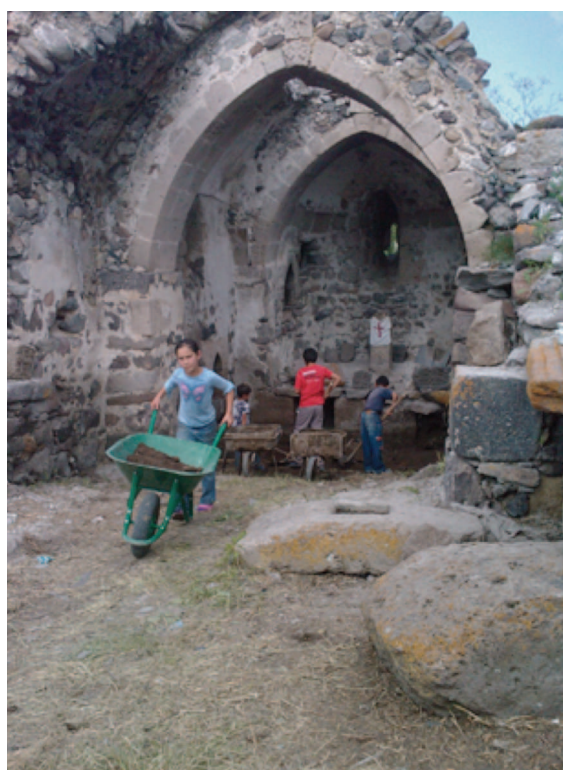
Église d'Azad : état initial et déblaiement superficiel (2007).
